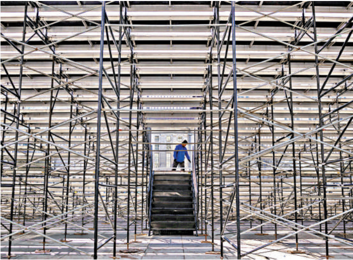
▲建築工人正在賓夕法尼亞大道上的檢閱台施工。路透社
