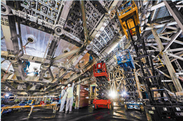
▲江門中微子實驗站去年完成實驗探測器主體建設。
