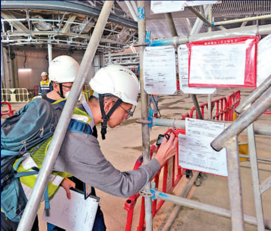
▲勞工處人員昨日巡視赤鱗角機場一個建築地盤，檢視地盤的金屬棚架。
