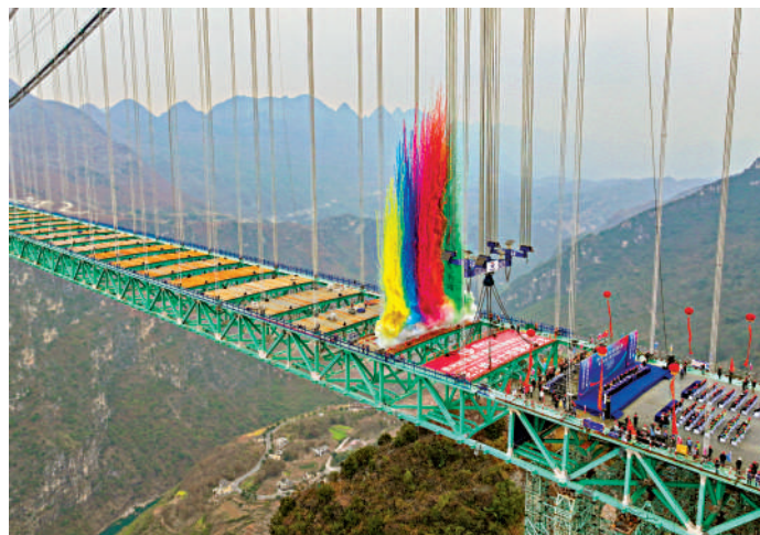
▲花江峽谷大橋合龍儀式現場。
