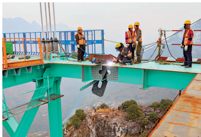
▲工人在花江峽谷大橋合龍現場施工。
