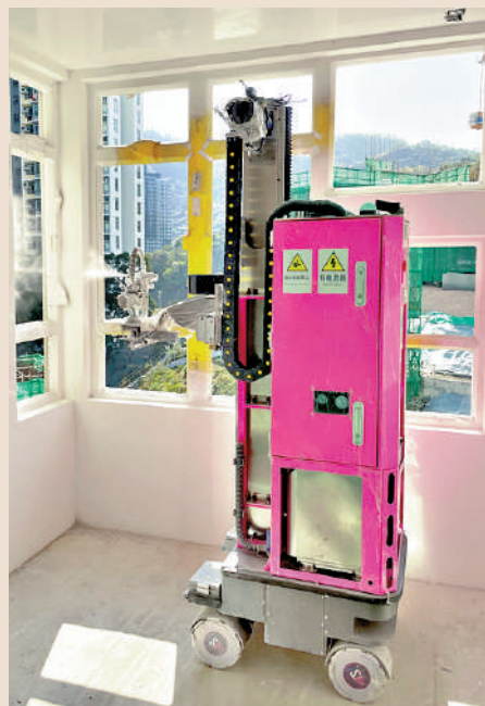
▲房委會審視增加應用建築機械人的工序部分，提升工地安全及建造效率。圖為機械人進行室內噴塗。
