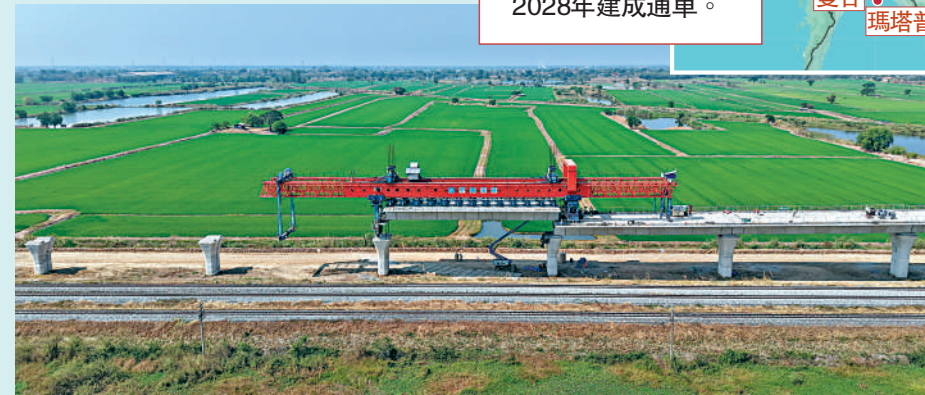
1月30日在泰國大城府拍攝的中泰高鐵項目4-3標段施工現場。
