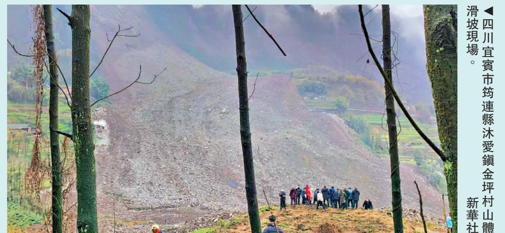
四川宜賓市筠連縣沐愛鎮金坪村山體滑坡現場。新華社
