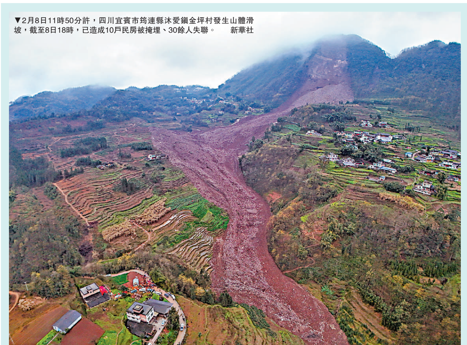
▼2月8日11時50分許，四川宜賓市筠連縣沐愛鎮金坪村發生山體滑坡，截至8日18時，已造成10戶民房被掩埋、30餘人失聯。新華社
