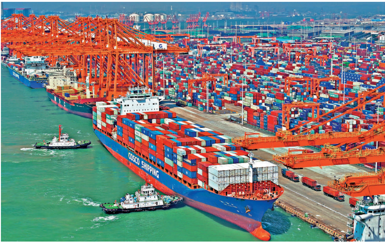
▲廣西北部灣港至香港公共班輪航線「天天班」常態化已開行，並與西部陸海新通道多式聯運班列對接，實現海陸聯通。圖為廣西北部灣港欽州港區碼頭的繁忙景象。
