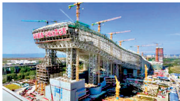
▲深圳「大」冰雪地標「華發冰雪大世界」目前還在建設中。
