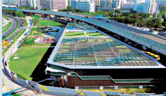
▲啟德發展區現時使用區域供冷系統。
