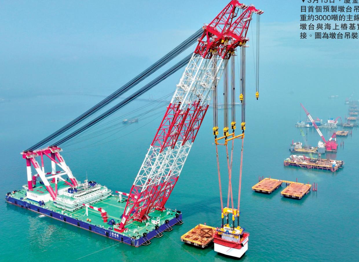
▼3月15日，廈金大橋（廈門段）項目首個預製墩台吊裝作業圓滿完成，重約3000噸的主線橋樑右幅35號預製墩台與海上樁基實現毫米級精準對接。圖為墩台吊裝現場。受訪者供圖
