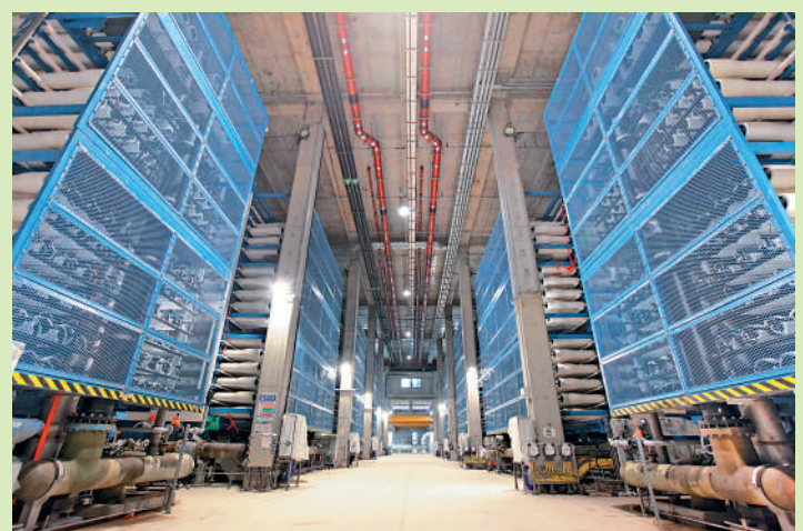
▲將軍澳海水化淡廠於2023年12月開始投產。圖示化淡廠的逆滲透淨化大樓。
