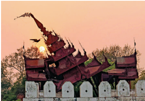
▲緬甸古蹟曼德勒皇宮在地震中嚴重受損。
