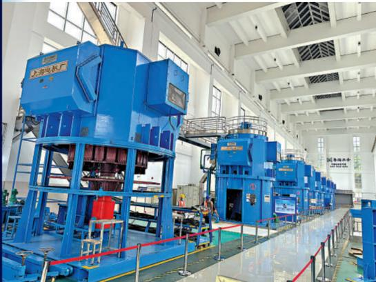
▲泵站內的水泵是讓水逆流的關鍵機器，這是金湖泵站的水泵，東江水在經過這個泵站後，水位已到達海拔46米。
