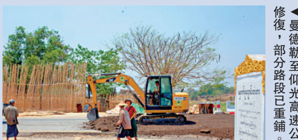
▲曼德勒至仰光高速公路加速修復，部分路段已重鋪。
