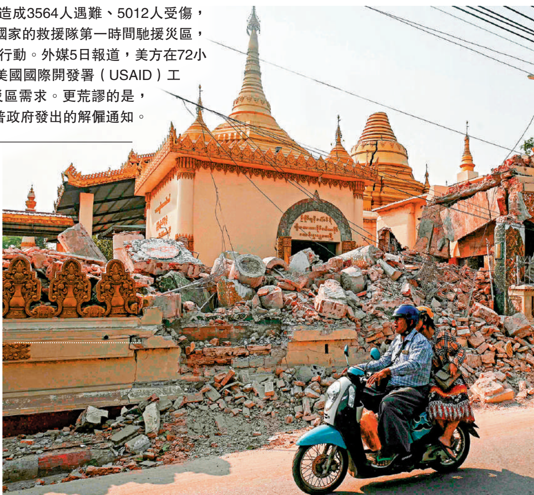
▲緬甸發生7.9級地震後，曼德勒市當地數千棟建築物、佛塔倒塌。法新社
