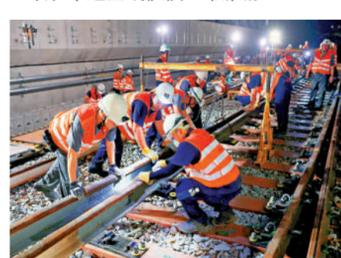
東涌綫延綫項目正在現有東涌站和欣澳站之間興建新的東涌東站。為配合東涌東站的新軌道，港鐵須進行大型改道工程，分四次進行關鍵道岔安裝工序。首次道岔安裝工序已於去年十月完成，餘下兩次預計將分別於2026年及2027年進行。
