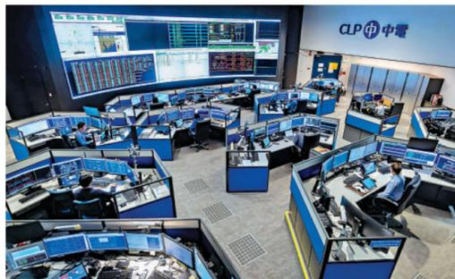
▲現時的中電的系統控制中心，全天候監察各區輸電、配電情況。
