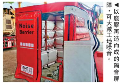
▲以廢膠再造而成的隔音屏障，可大減工地噪音。
