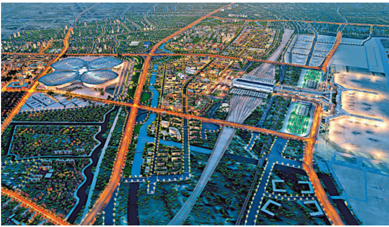
▲從空中俯瞰虹橋國際中央商務區，這裏已經成為上海和長三角新地標。
