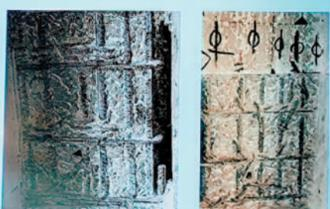
▲調查發現，有鋼筋移位最多達530毫米。
