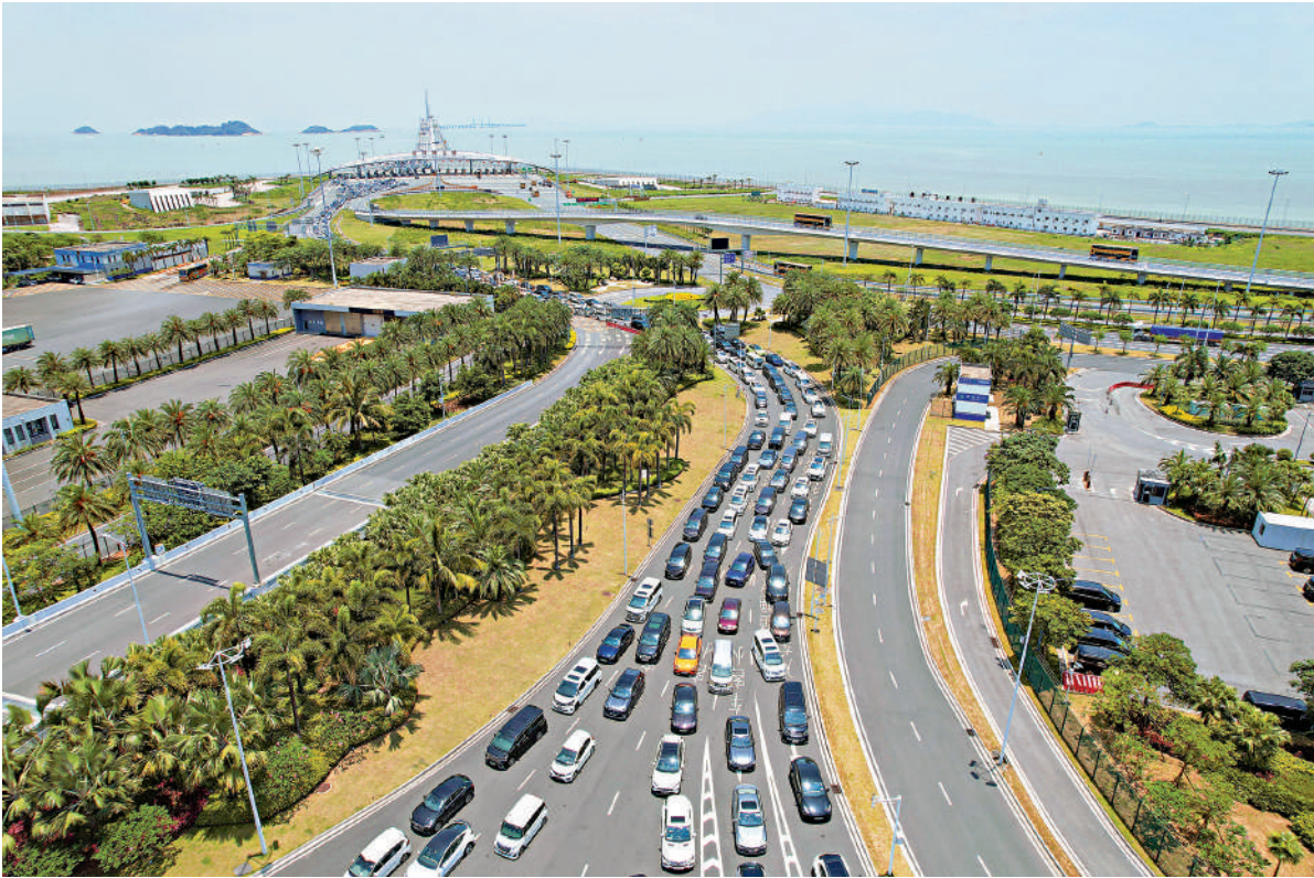
▲港珠澳大橋是一座承載區域融合、制度協同、經濟一體化的重要橋樑。
