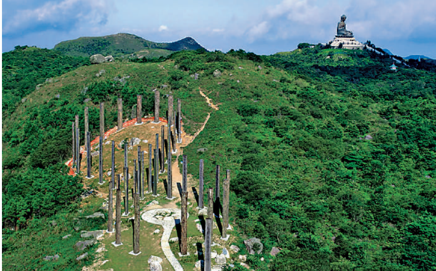
◀「心經簡林」於6月5日起暫停開放以進行翻修工程。
