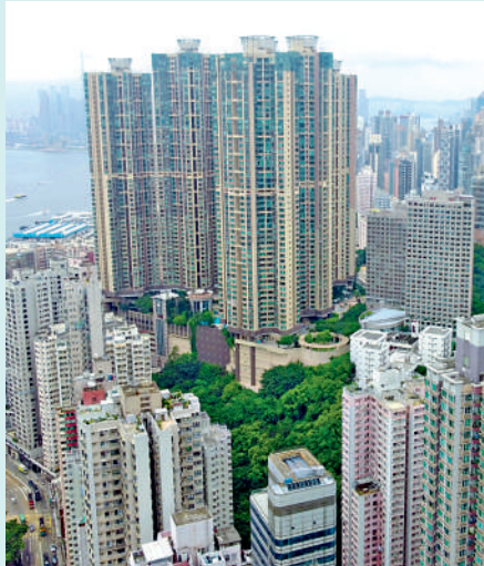
▲部分新盤向隅客轉投二手市場，加上多個屋苑供平過租，預期本月二手市場較5月暢旺。
