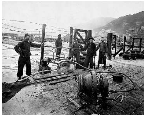
▲香港首條跨海管道於1930年3月完成。圖為當時工人進行跨海管道的水壓測試工序。
