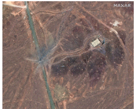
▲暫無有關伊朗福爾多核設施受損情況的全面評估。
