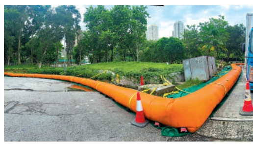
▲渠務署在大埔林村河廣福橋附近放置臨時充水式擋水壩。
