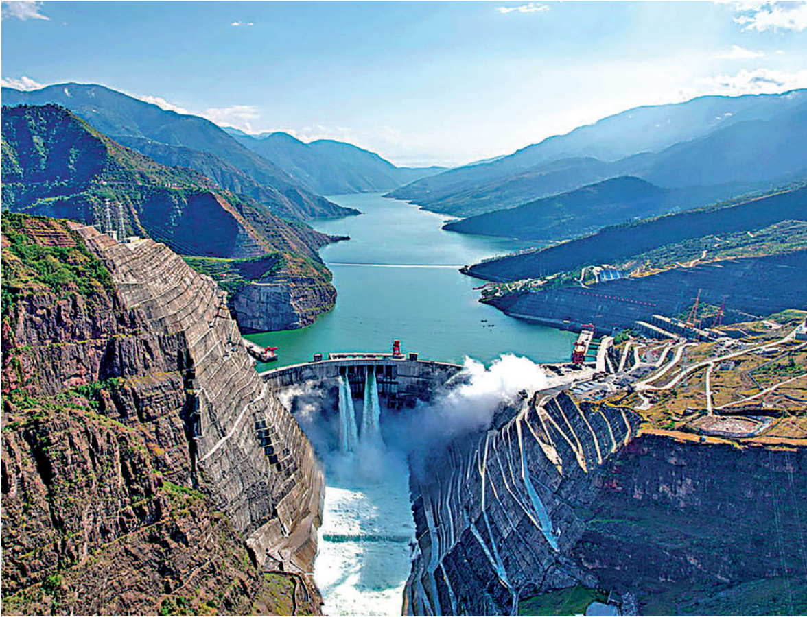
▲白鶴灘水電站位於四川省寧南縣和雲南省巧家縣交界的金沙江幹流河段上，總裝機容量208萬千瓦，是我國實施「西電東送」的國家重大工程，共安裝16台，總機組容量最大功率百萬千瓦水輪發電機組。新華社
