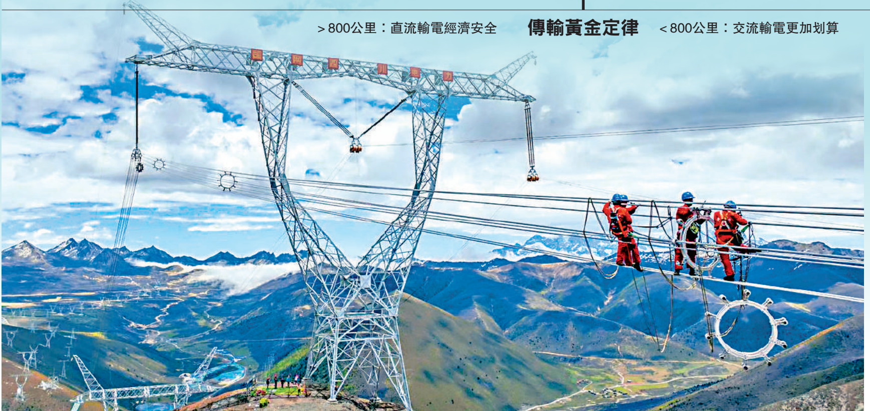
▲2024年12月27日，我國西南地區首個特高壓交流輸電工程——國家電網川渝1000千伏特高壓交流工程正式投運。圖為施工人員在川渝特高壓交流工程架線施工。
