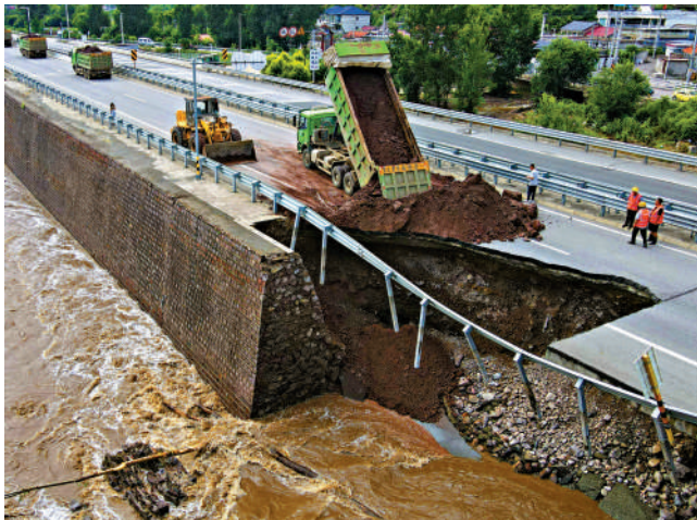
▲7月28日，北京市懷柔區111國道古石溝門橋因為連日暴雨導致路基被沖毀，大型工程機械在回填路基，加快搶修。中新社
