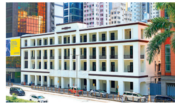
▲國際調解院總部大樓正式竣工，總部大樓於8月1日正式交付國際調解院籌備辦公室。
