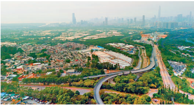
▲土木工程拓展署就新田科技城地盤平整工程刊憲招標，料有關工程於今年12月展開。
