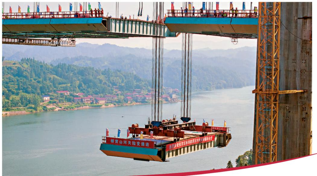
▲8月3日，在張官高速洞庭溪沅水特大橋施工現場，一塊鋼混結合樑在被緩緩提升。 新華社
