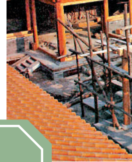
▶重建之中的「建福宮花園」，修復方式依照古建八
