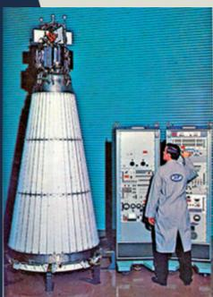
▲美國的SNAP-10A核裂變電源系統。網絡圖片
