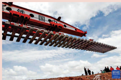
▲ 2004年6月22日，西藏境內第一段鐵路軌排在安多火車站鋪下。
