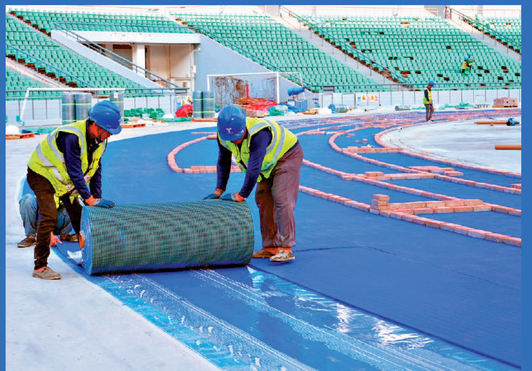
▲廣州攜手「城市合夥人」共同辦好全運會賽事，跑道供應商為核心場館提供最高規格的賽事級預製型橡膠跑道。圖為工人在廣州大學城體育中心鋪設跑道。受訪者供圖
