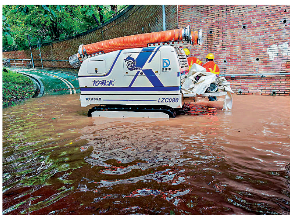
彩園邨和彩蒲苑往粉錦公路的行人隧道水浸，渠務署即時派出緊急應變隊伍及強力排水機械「龍吸水」處理。
