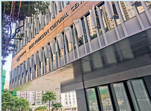
▲東九文化中心外觀一角，其外牆可見鐵閘設計。 大公報記者劉毅攝
