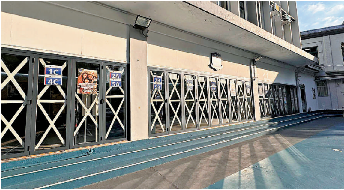
◀德萃小學在颱風來臨前做足加固大型設施等防風措施，盡力確保周四能夠復課。
