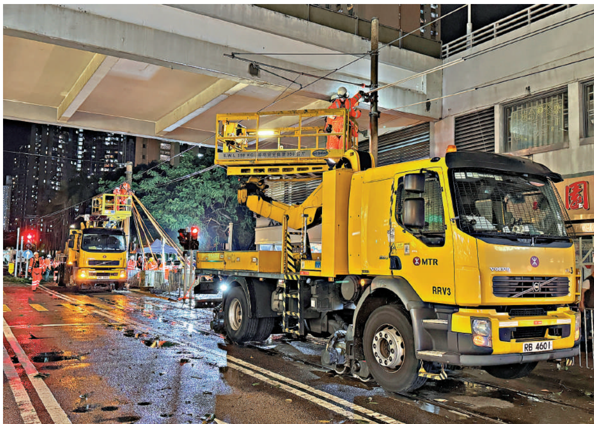
▲港鐵工人昨晚緊急搶修受損電纜。
