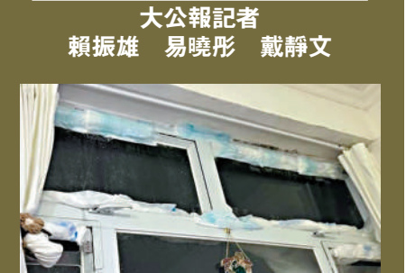
▲有網民使用液態衛生巾封窗邊，成功防止漏水。
