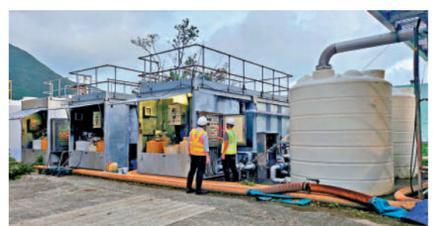
渠務署將污水引流至淺水灣總污水泵房旁的緊急應變污水處理設施。
