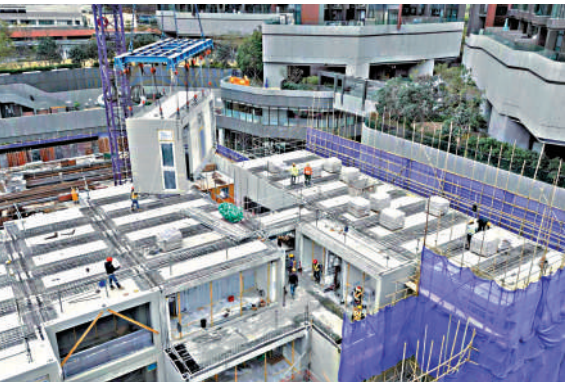
▲「組裝合成」技術透過「先裝後嵌」，提升工地生產力。
