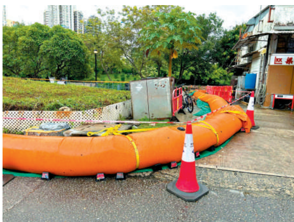
▲渠務署引入新的臨時充水式擋水壩，可根據不同地形而彎曲，更符合需要。
