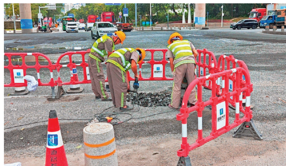
▲10月21日，在深圳鹽田，施工人員對「捲尺哥」視頻展示的路面展開維修。
