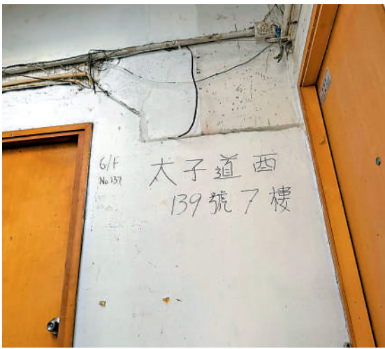
▲同一樓層住戶要在牆壁上寫上街號來區分單位號數。
