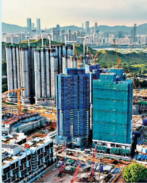
延期樓盤：古洞北項目 發展商：會德豐地產
