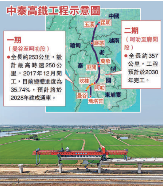
▲今年1月在泰國大城府拍攝的中泰高鐵項目4-3標段施工現場。 新華社
