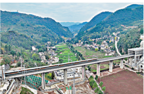
▲試運管列車經過盤興高鐵路妥樂隧道和魯番隧道之間的橋樑。林劍攝
